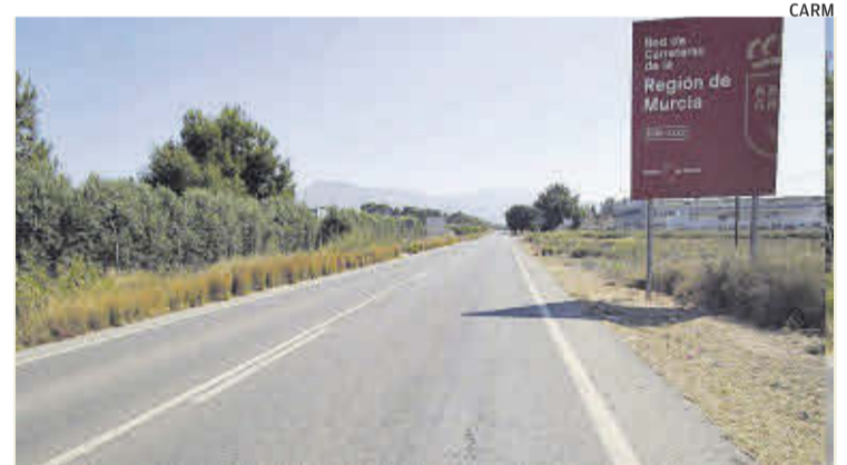
Una de las vías donde se mejorará el firme.
